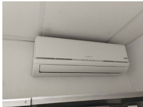
Imagen 10. Unidad interior tipo Split de pared
