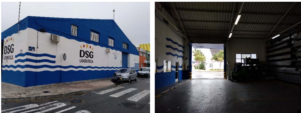
Imagen 2. Fachada +Cubierta zona Nave
