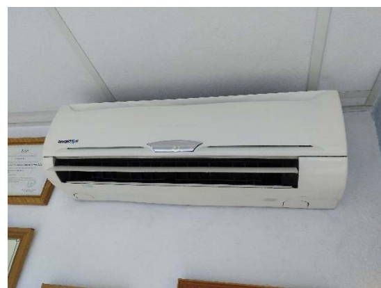
Imagen 12. Unidad interior tipo Split de pared
