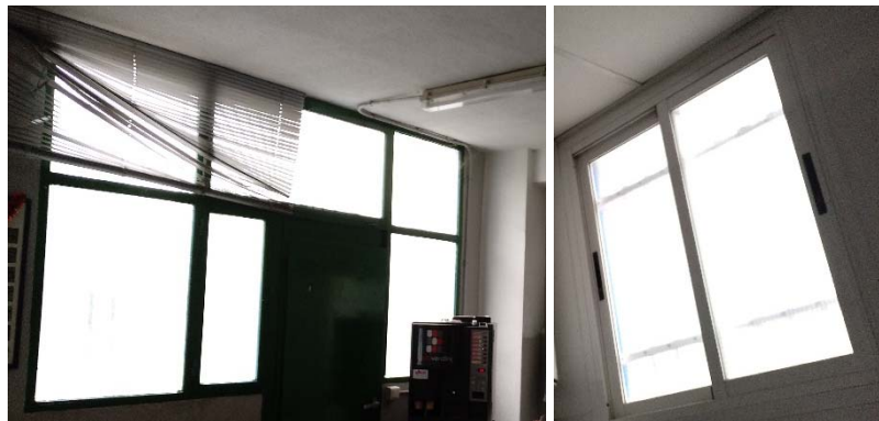
Imagen 3. Carpintería metálica con vidrio monolítico
